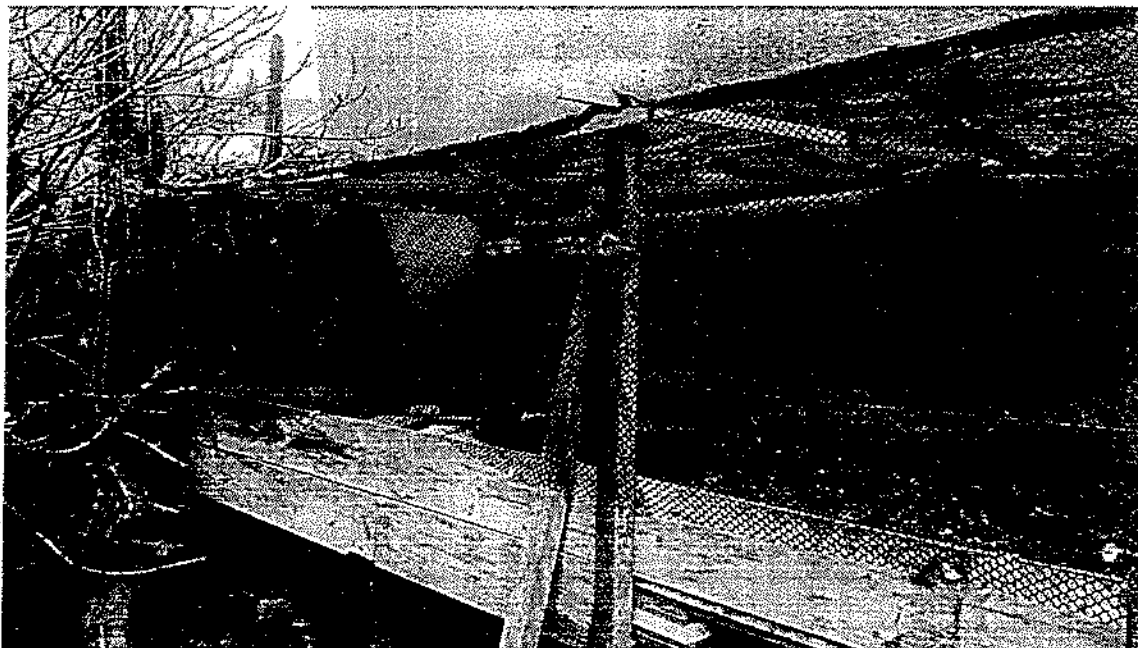
Figura 3. Instalação do Sombrite e tela de galinheiro
