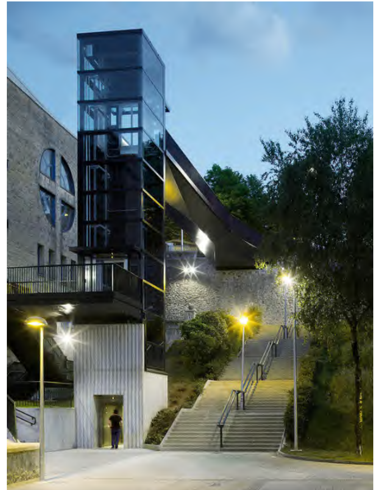
Figura 56 – Vista Frontal, elevador e escadaria.
