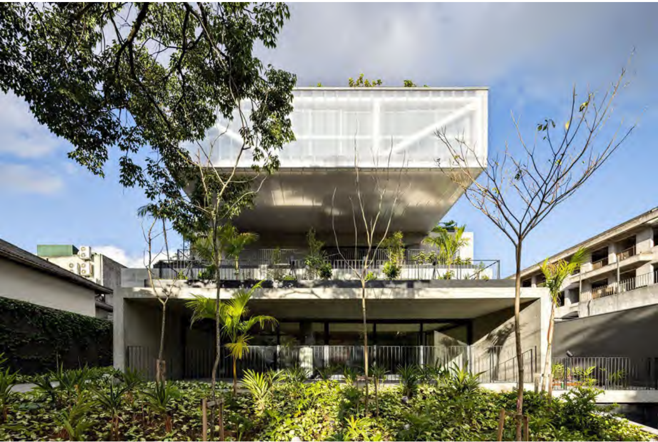
FIGURA 46 - VISTA FRONTAL DO EDIFÍCIO GIRASSOL
