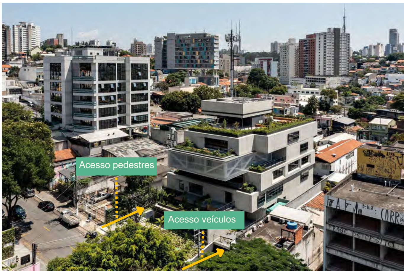
FIGURA 50 - EDIFÍCIO E ENTORNO
