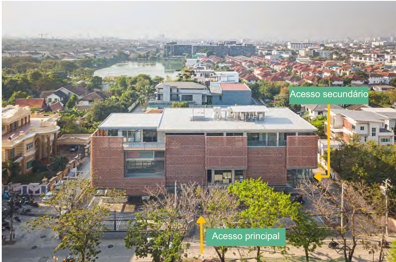
FIGURA 85 - EDIFÍCIO E ENTORNO
