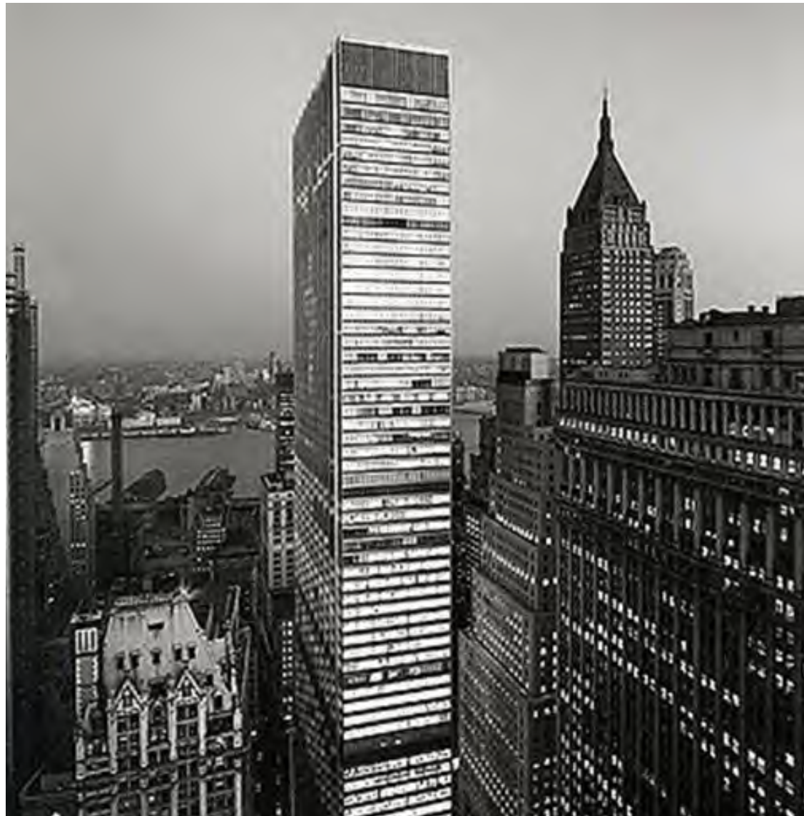
FIGURA 5 - EDIFÍCIO ONE CHASE MANHATTAN (1961) – SOM. MANHATTAN
