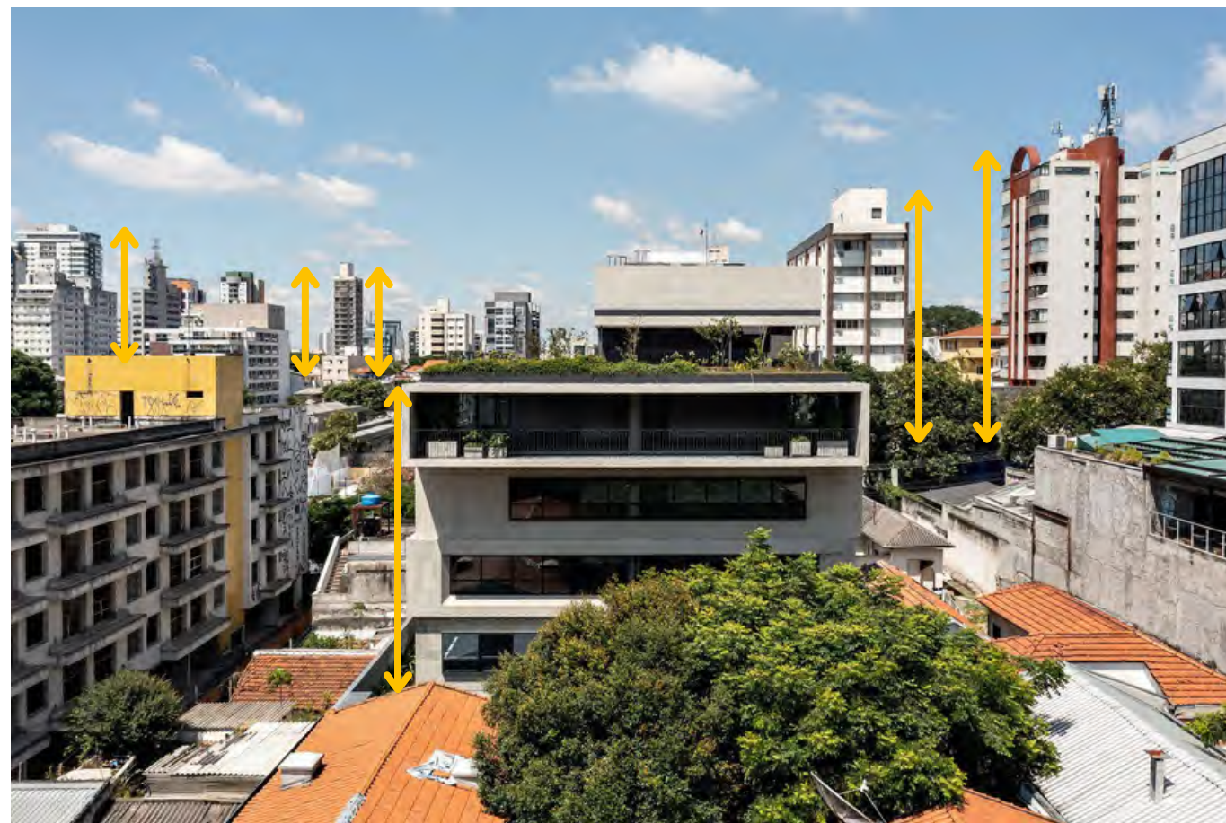
FIGURA 51 - EDIFÍCIO E ENTORNO
