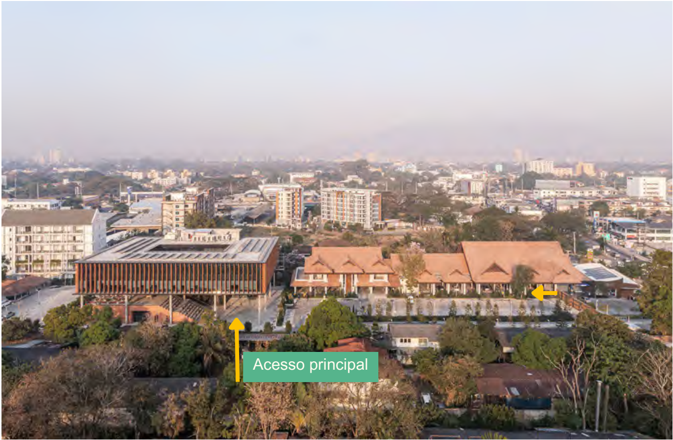
FIGURA 126 - EDIFÍCIO E ENTORNO
