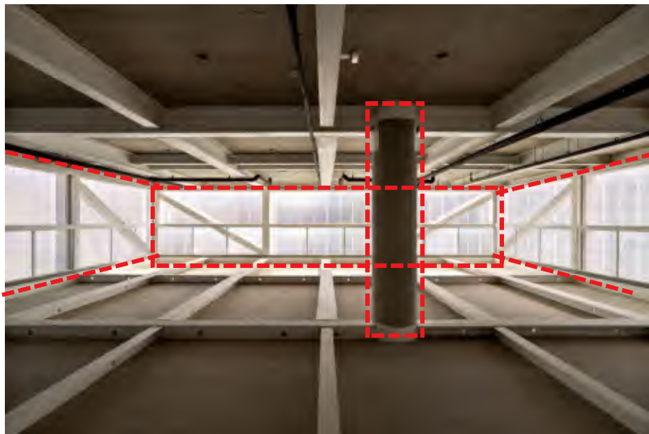
FIGURA 65 - ESTRUTURA TERCEIRO PAVIMENTO
