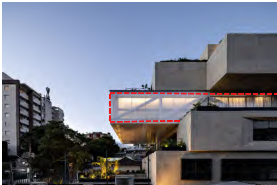
FIGURA 66 - BALANÇO DE 7 METROS TERCEIRO PAVIMENTO
