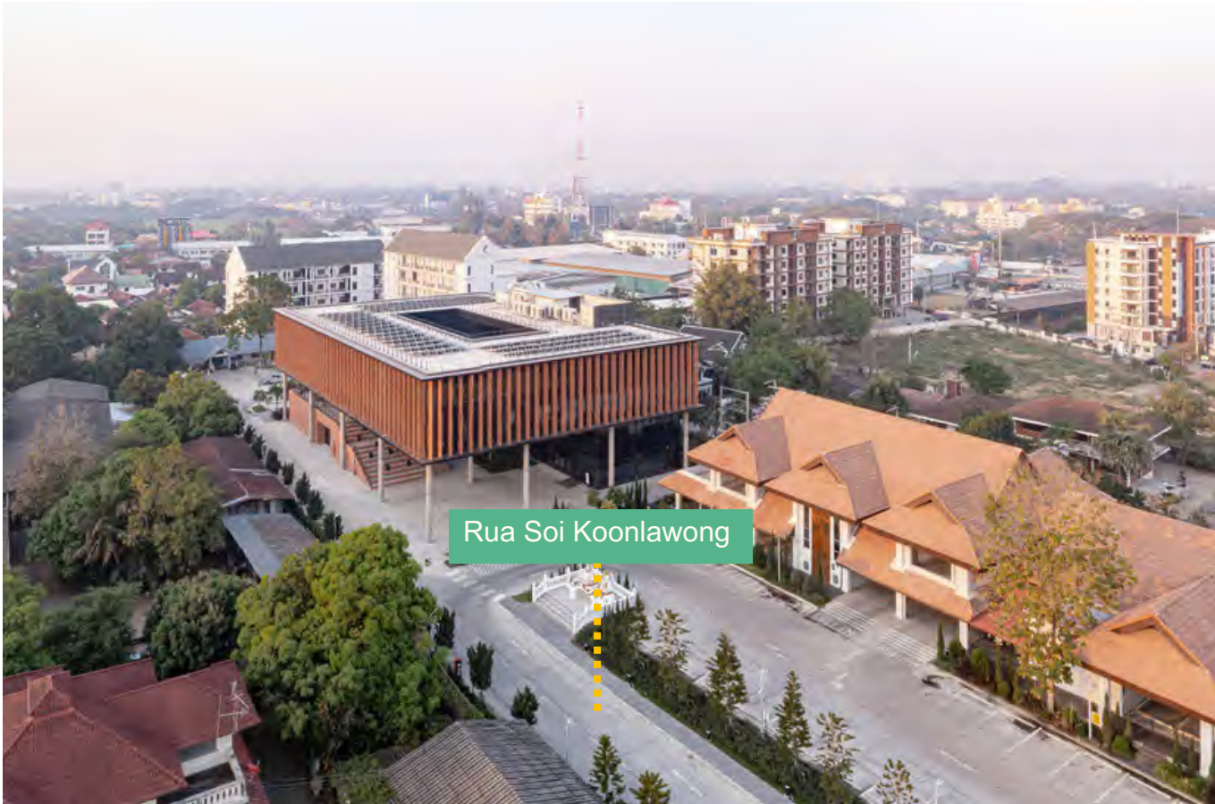
FIGURA 127 - EDIFÍCIO E ENTORNO
