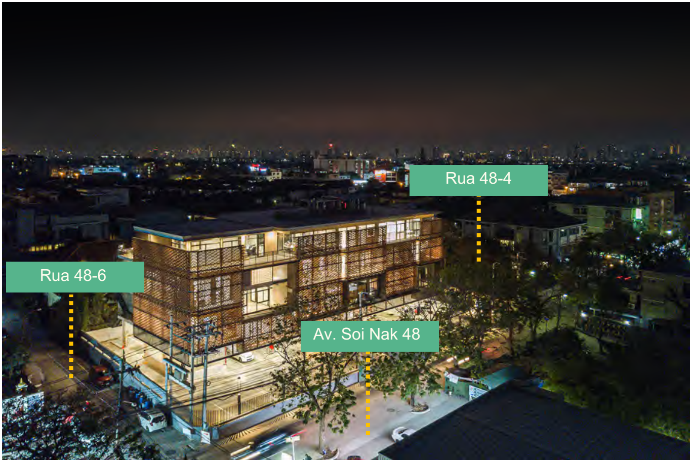
FIGURA 86 - EDIFÍCIO E ENTORNO
