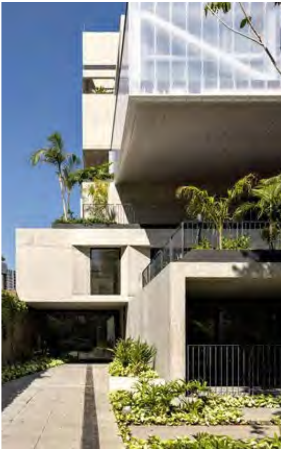
IMAGENS TÉRREO E PRIMEIRO PAVIMENTO
