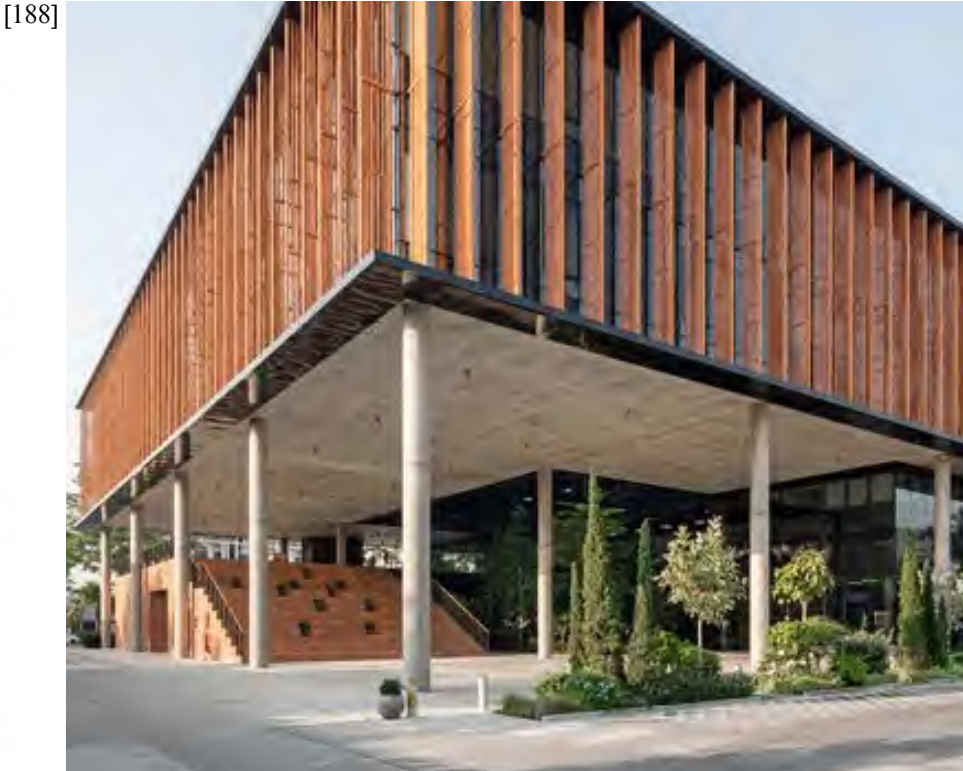
IMAGENS TÉRREO E PRIMEIRO PAVIMENTO
