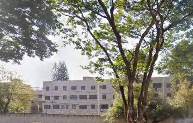
Figura 64 Exemplo de edificação de 2 a 4 pavimentos Fonte: Google StreetView, disponível em https://earth.google.com/web/search/alto+da+boa+vista , acesso em mai. 2024
