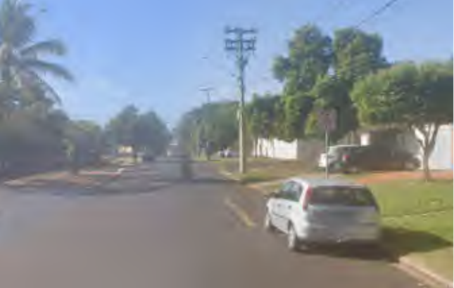
Figura 84 Exemplo de via coletora Fonte: Google StreetView, disponível em https://earth.google.com/web/search/alto+da+boa+vista , acesso em mai. 2024
