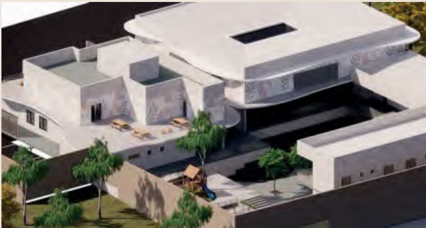
Figura 87 - Fachada posterior - Rua Aurelino Garcia de Oliveira
