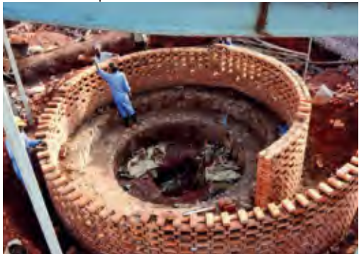
Figura 18 - Construção da sala com tijolos produzidos local
