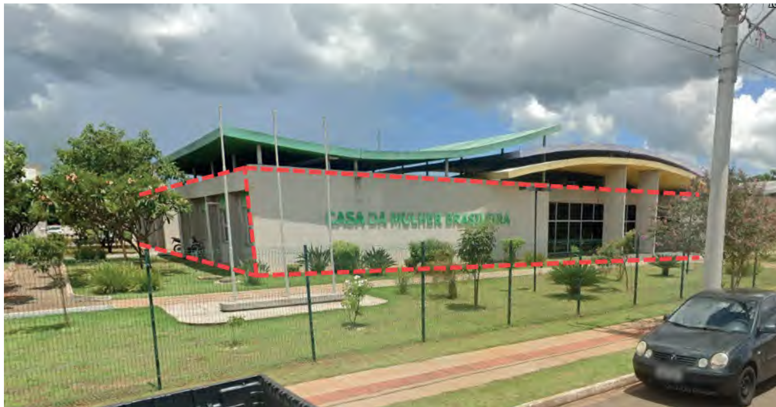
Figura 43 - Fachada CMB Campo Grande - MS.
