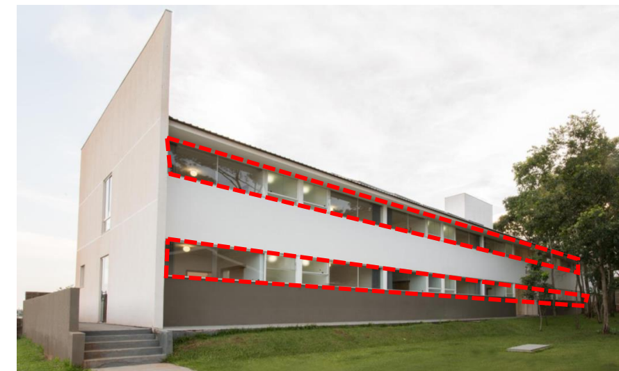
Figura 50: Imagem aérea, com marcação das aberturas do dormitório- Centro São Pio
