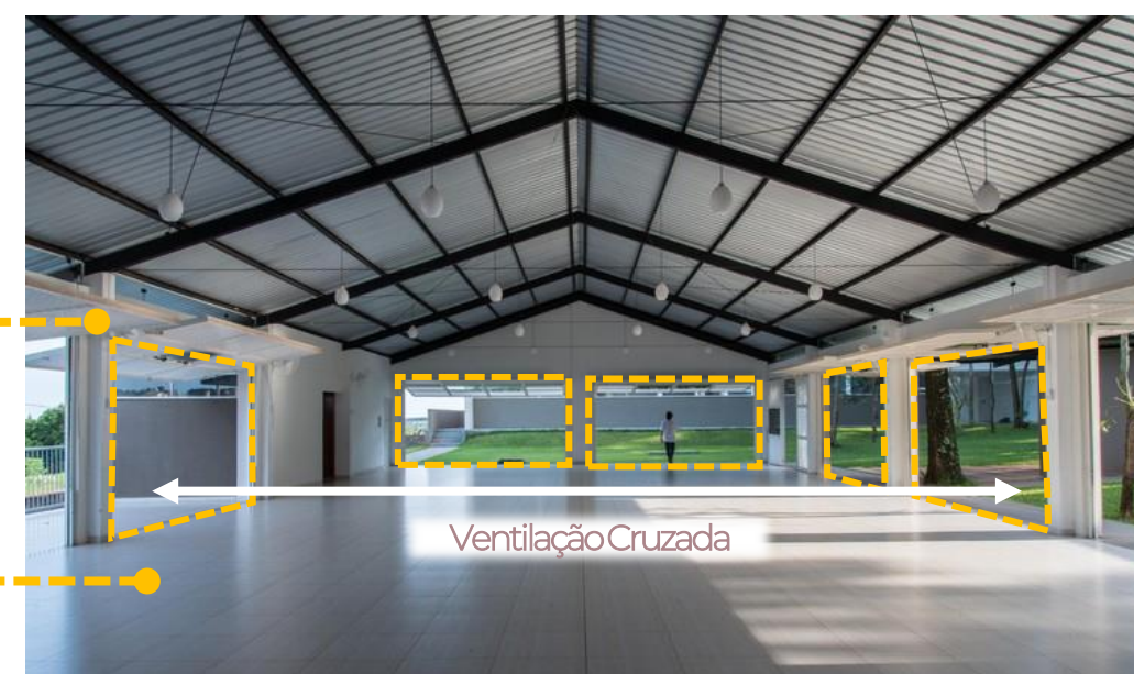
Figura 56: Imagem externa, com marcação dos elementos de adequação climática – Centro São Pio Fonte: Archdaily, 2024. Adaptação gráfica: Autora, 2024.
