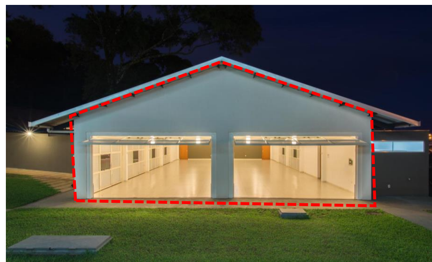
Figura 47: Imagem aérea, com marcação da volumetria do refeitório- Centro São Pio Fonte: Archdaily, 2024. Adaptação gráfica: Autora, 2024.
