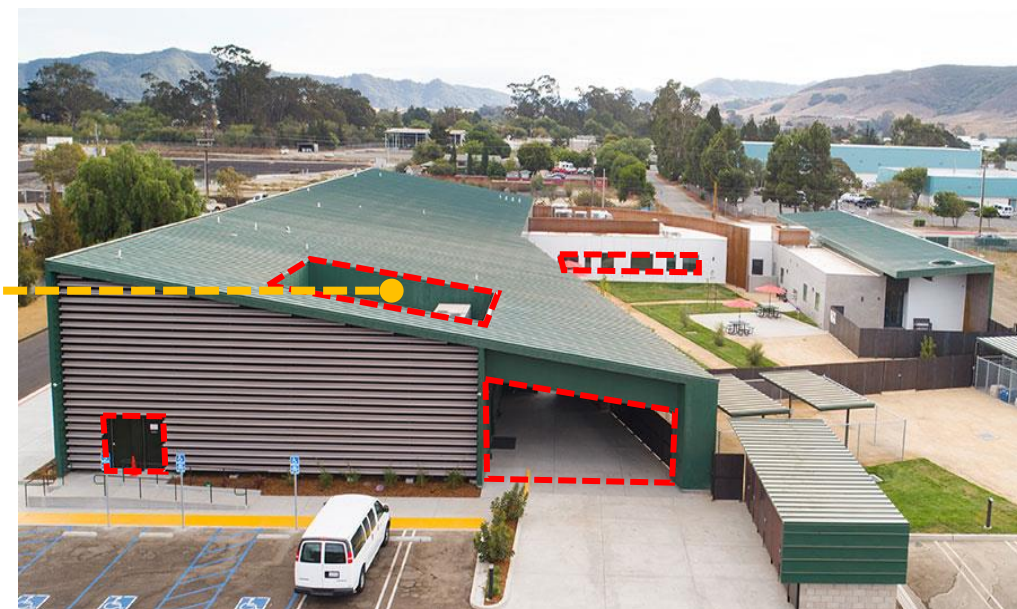
Figura 69: Imagem aérea, com marcação das aberturas da fachada – Capslo Homeless Services Center Fonte: Gwynne Pugh Estúdio Urbano. Adaptação gráfica: Autora, 2024.
