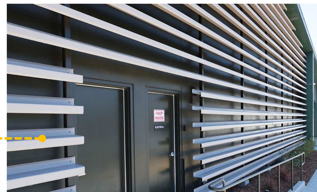
Figura 74: Imagem externa, com marcação dos elementos de adequação climática – Capslo Homeless Services Center
