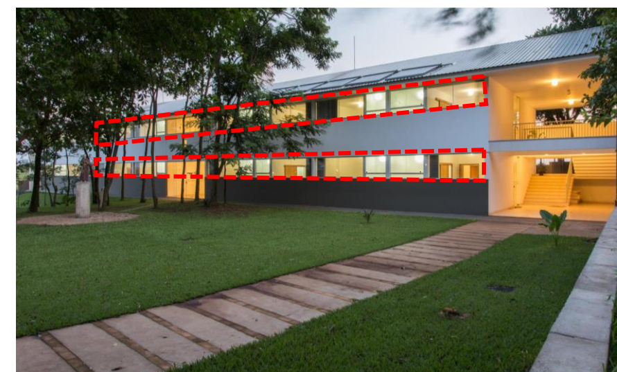
Figura 52: Imagem aérea, com marcação das aberturas do dormitório- Centro São Pio
