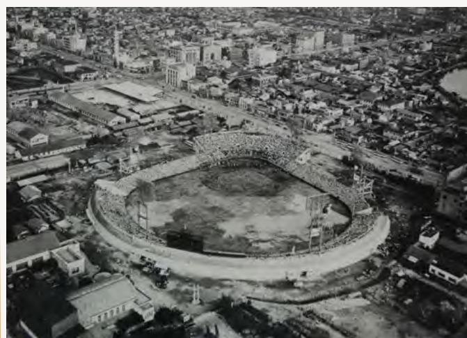
Figura 67 - Construção do Estádio
