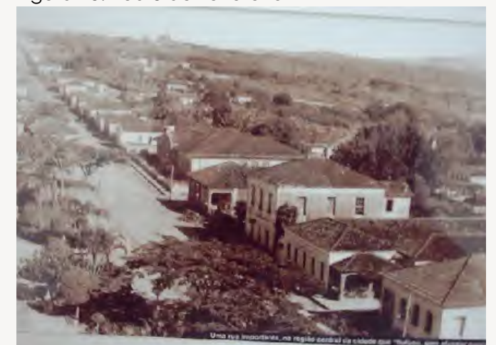
Figura 15: Rua 3 de Fevereiro
