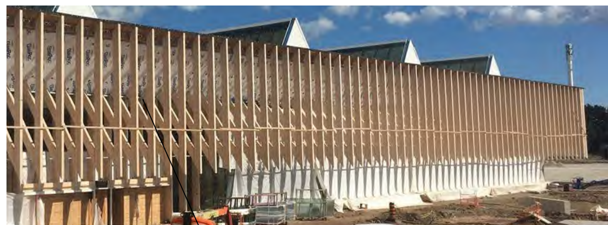
ESTRUTURA DE MADEIRA
