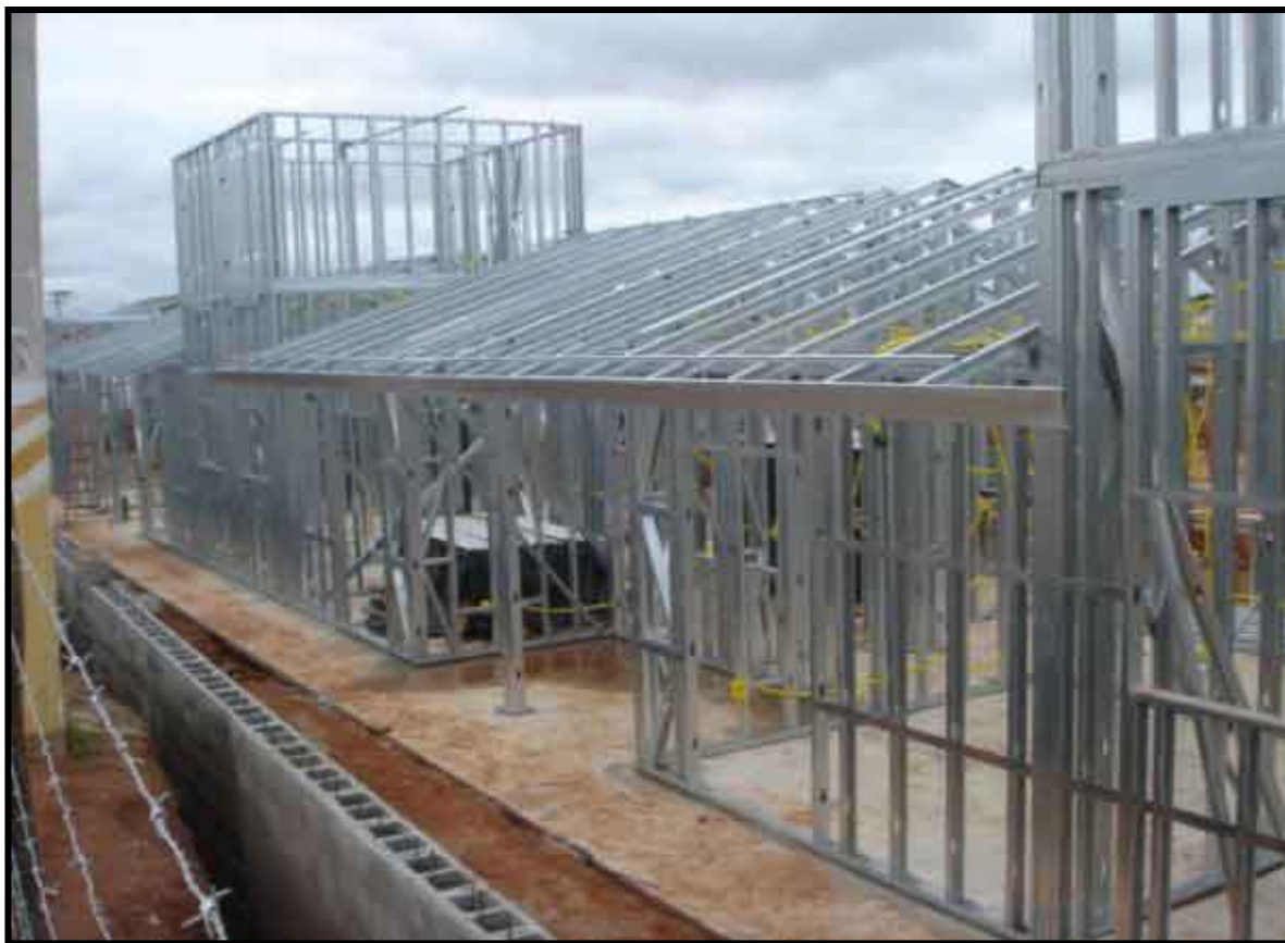
Figura 03 - Steel Frame em construção de residências populares – CDHU (Companhia de Desenvolvimento Habitacional e Urbano) em Avaré-SP.
