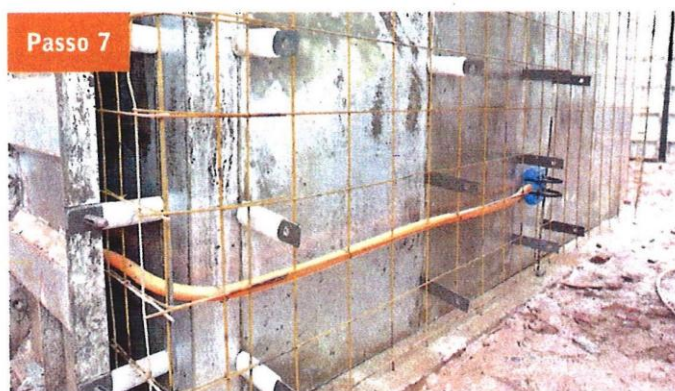
6 Primeiro, são montadas as fôrmas das faces internas da edificação, conforme as orientações do fabricante dos painéis.
