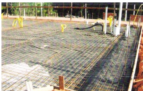
Radier pronto para ser concretado
