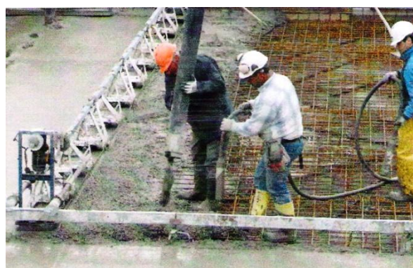
Radier sendo concretado
