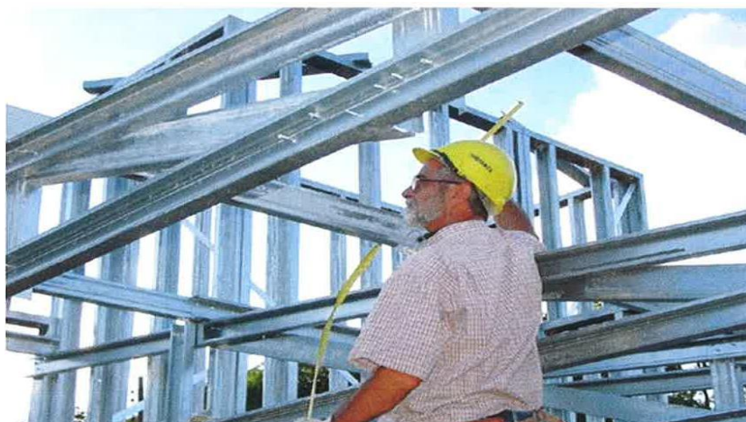
Figura 8: Montagem de Residência pelo Sistema LSF
