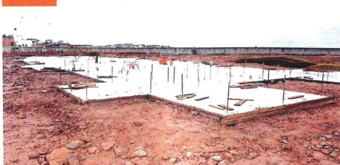
Figura 12: Etapas construtivas de execução de paredes utilizando concreto autoadensável
