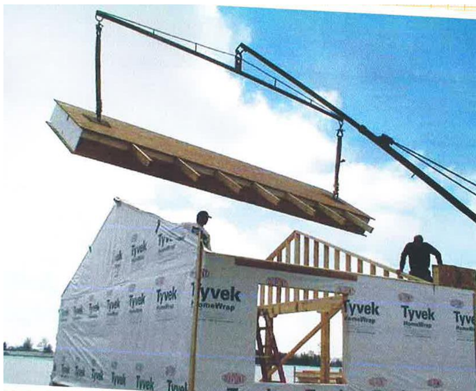
Figura 10: Sistema TILT UP de Montagem Construtiva
