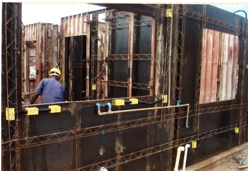
Figura 7: Inclusão das Instalações Prediais na Fôrma de Aço
