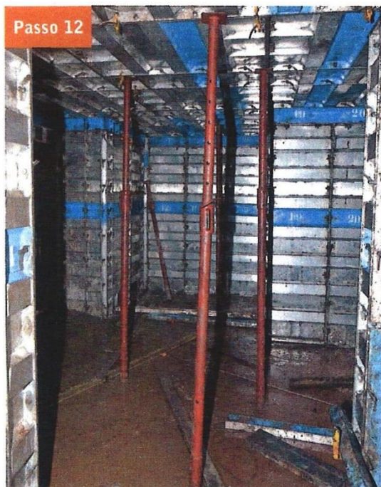
12 Nesta etapa são posicionadas as escoras para sustentação da laje superior durante o lançamento e a cura do concreto.
