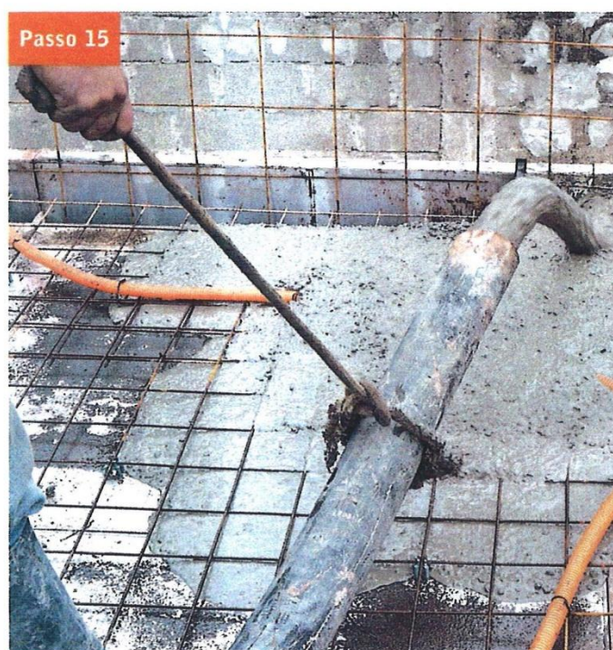
15 A conclusão da etapa de montagem, é feita a conferência pelo engenheiro ou mestre de obras. Depois disso, o concreto autoadensável é lançado no interior das paredes.
