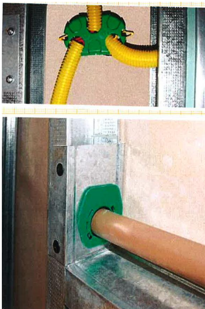
Figura 9: Instalações Prediais Hidráulicas e Elétricas no Interior do DRY WALL
