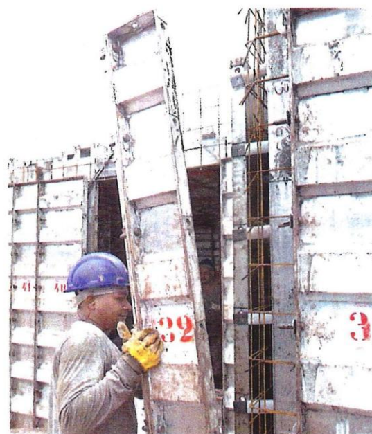
6 Primeiro, são montadas as fôrmas das faces internas da edificação, conforme as orientações do fabricante dos painéis.
