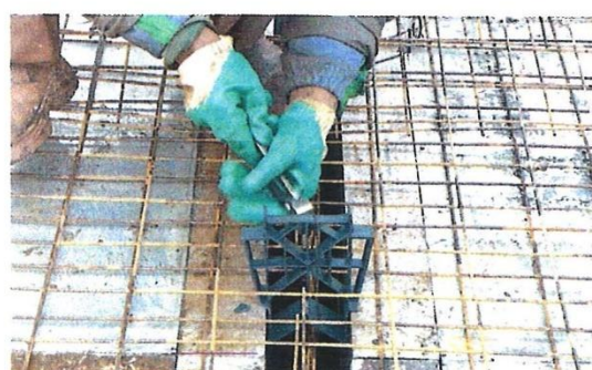
13 A armação da laje também é feita com uso de telas soldadas. Outro elemento que se repete é o espaçador, que mantém a armadura no lugar e garante o cobrimento mínimo pelo concreto, evitando problemas de corrosão por exposição.
