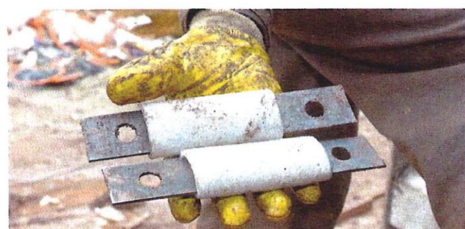
7 As gravatas de travamento, que fazem a ligação entre as faces das fôrmas, devem ser posicionadas nas fôrmas já montadas.
