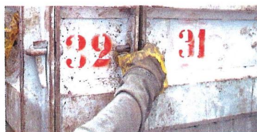
8 Veja como é feita a fixação entre as fôrmas paralelas – das duas faces – com uso das gravatas e dos pinos de travamento. Eles servem, ainda, para travar os painéis lateralmente.
