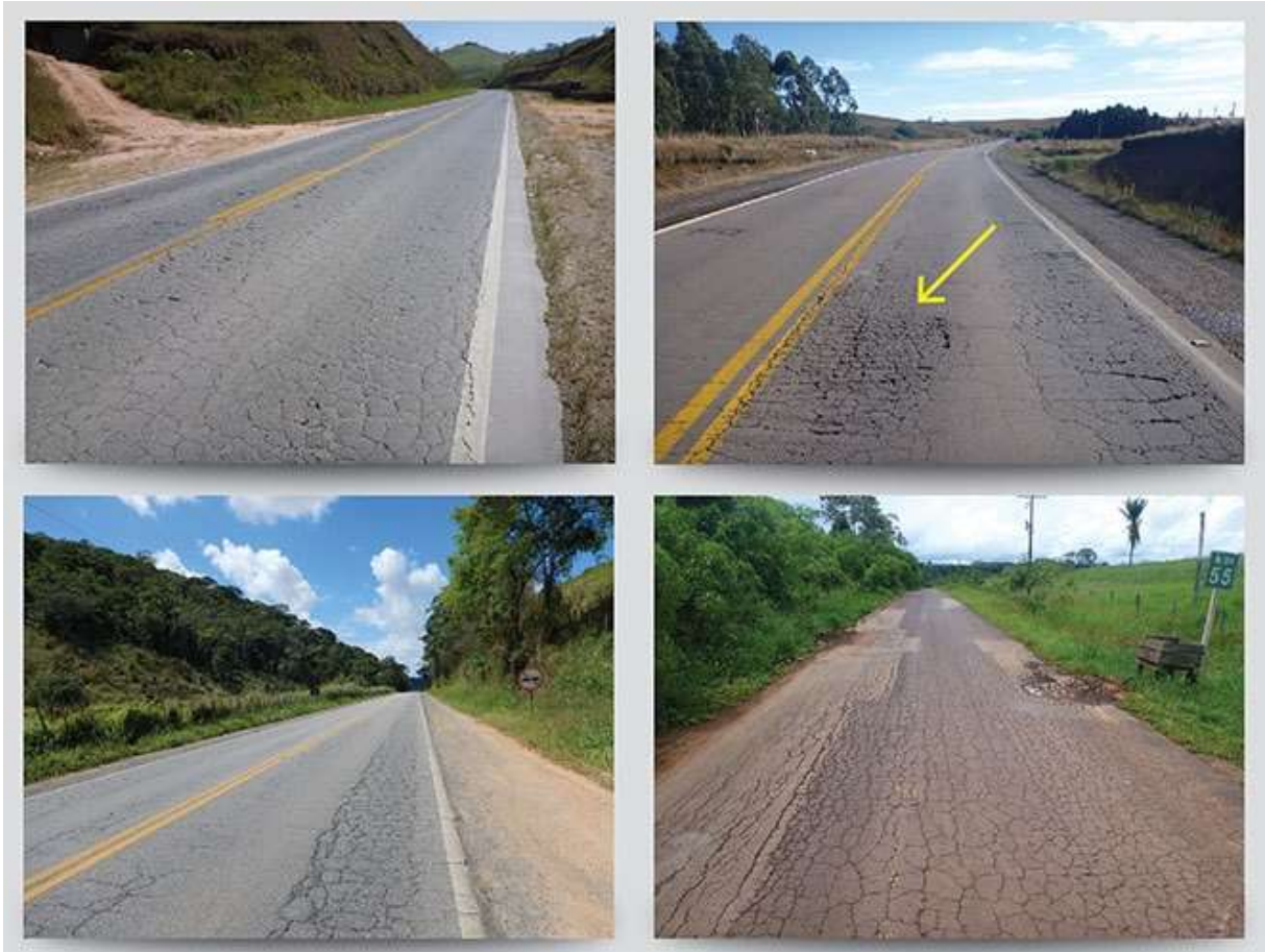
Figura 16 – Trincas em malhas encontradas nas estradas em que são transportados frangos vivos para abate
