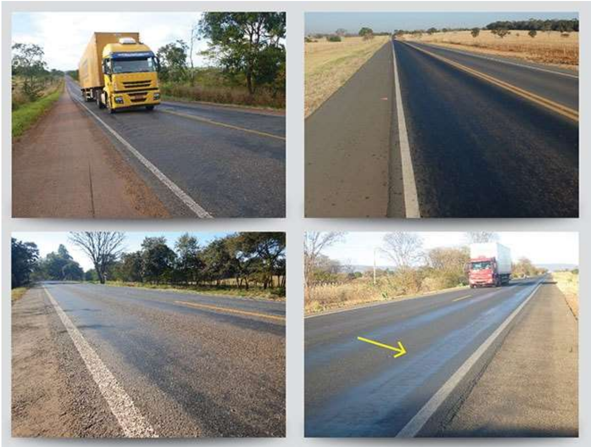
Figura 22 – Exemplos de exsudação que ocorrem em estradas onde são transportados frangos vivos para abate
