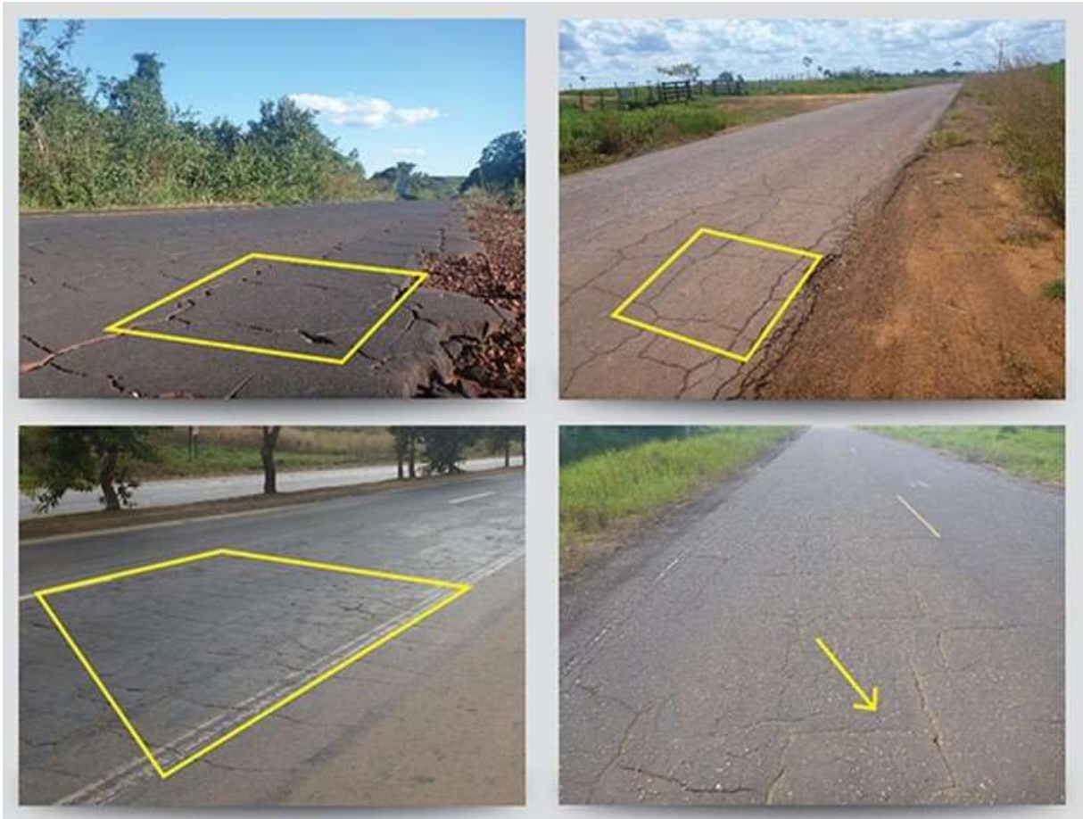
Figura 17 – Trincas de malha em bloco encontradas nas estradas em que são transportados frangos vivos para abate
