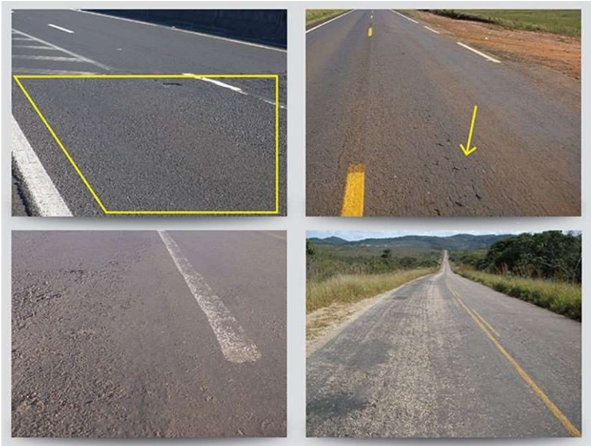
Figura 23 – Exemplos de defeito de desgaste que ocorre nas estradas em que são transportados frangos vivos para abate
