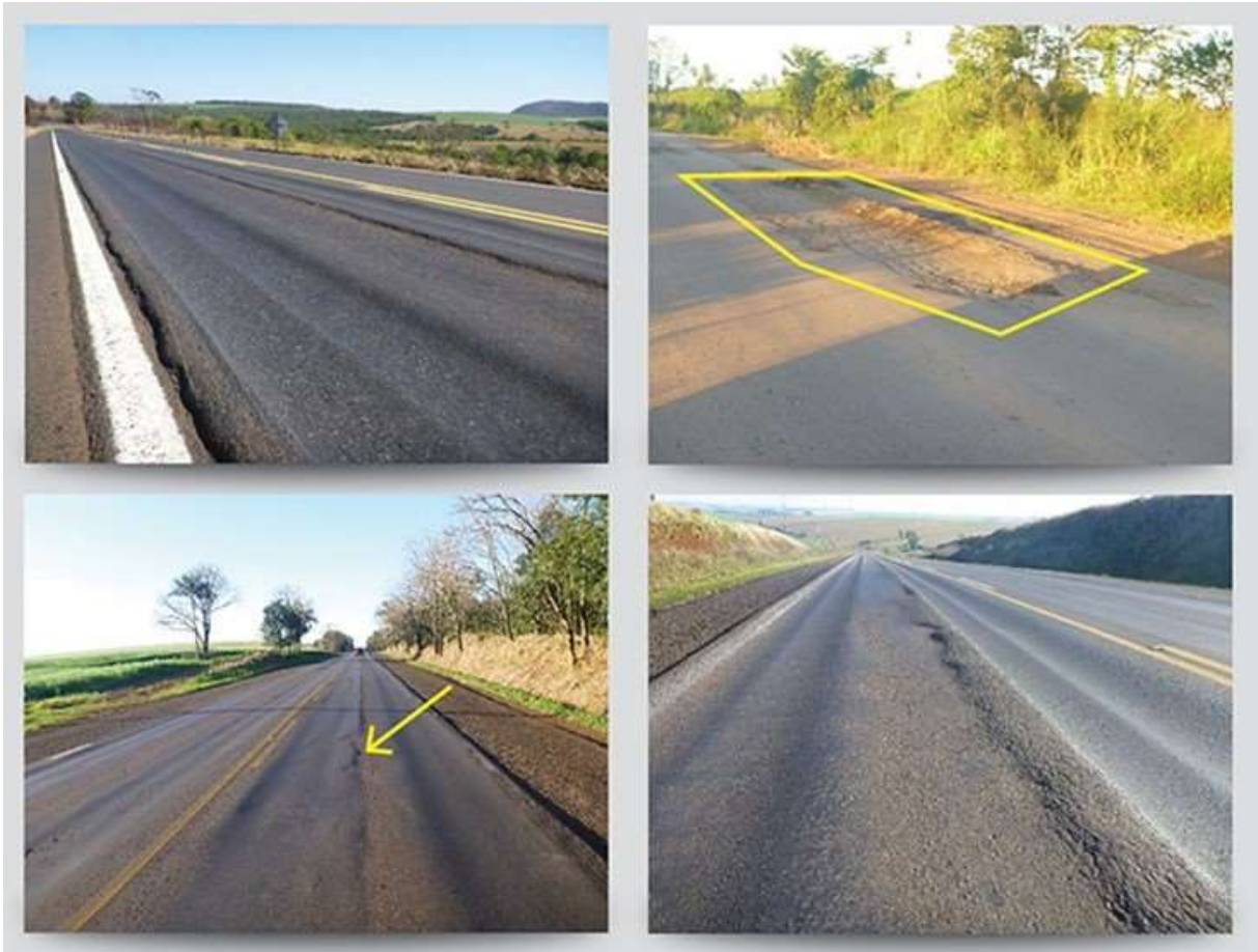
Figura 18 – Afundamento plástico encontrado nas estradas em que são transportados frangos vivos para abate
