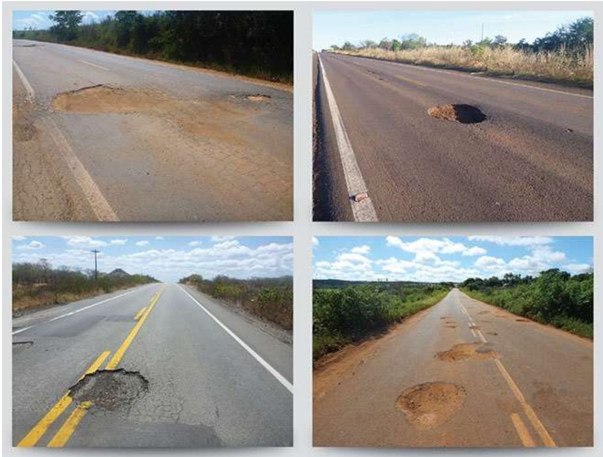
Figura 24 – Exemplo de panelas que ocorrem nas estradas em que são transportados frangos vivos para abate
