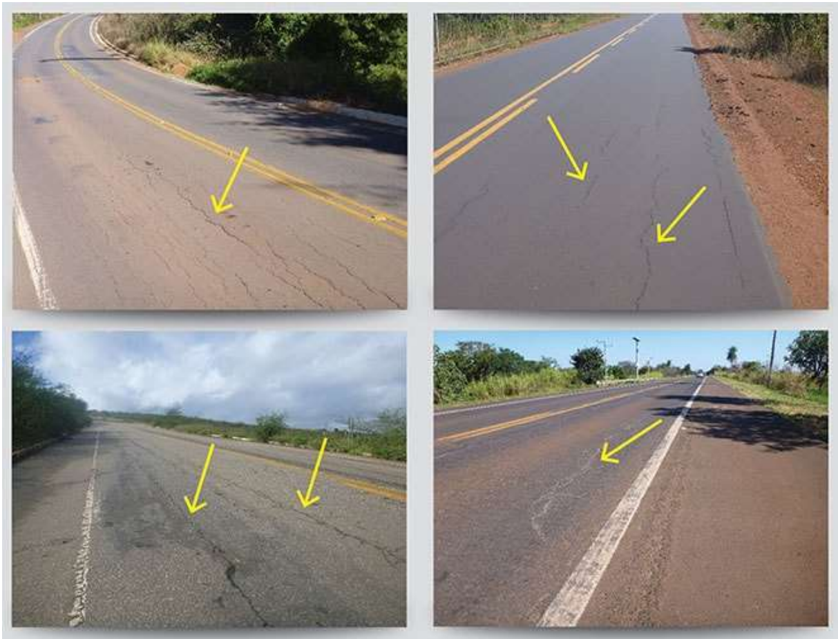
Figura 15 – Trincas longitudinais encontradas nas estradas em que são transportados frangos vivos para abate
