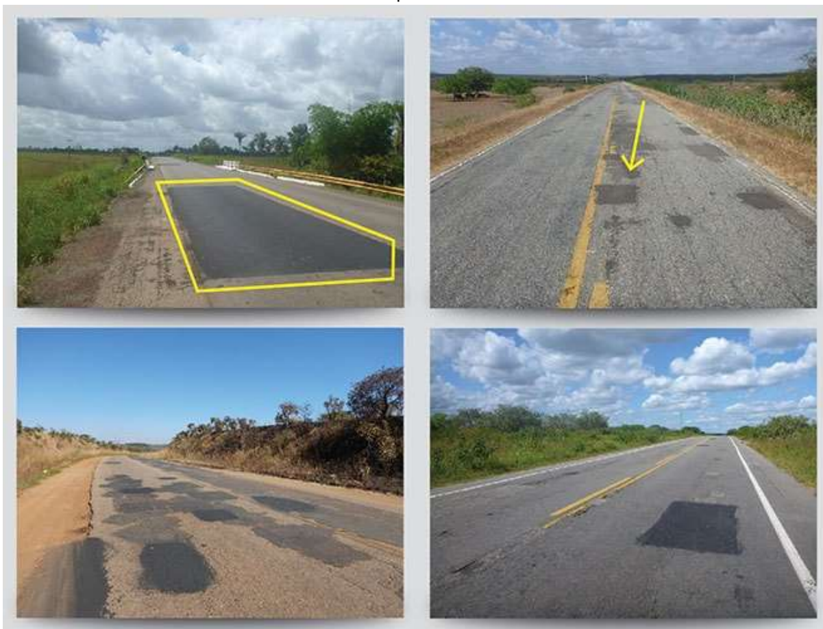
Figura 25 – Exemplos de remendos identificados nas estradas em que são transportados frangos vivos para abate
