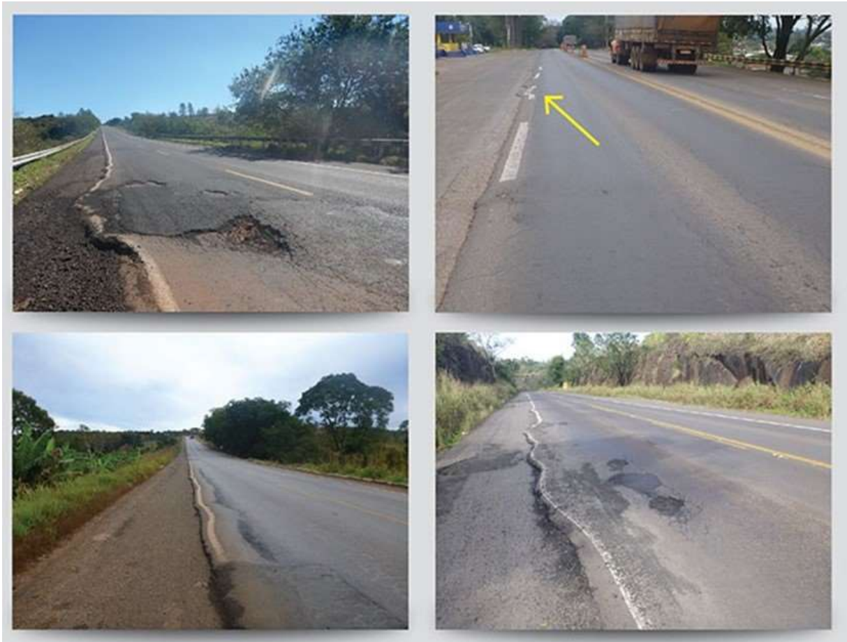
Figura 21 – Exemplos de escorregamento encontrado nas estradas em que são transportados frangos vivos para abate
