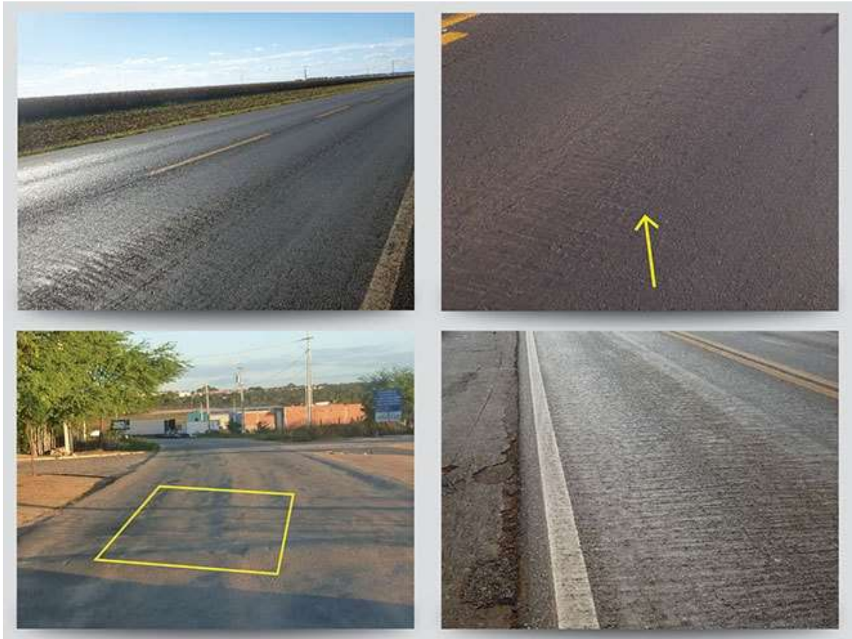
Figura 20 – Ondulação ou corrugação encontradas nas estradas em que são transportados frangos vivos para abate
