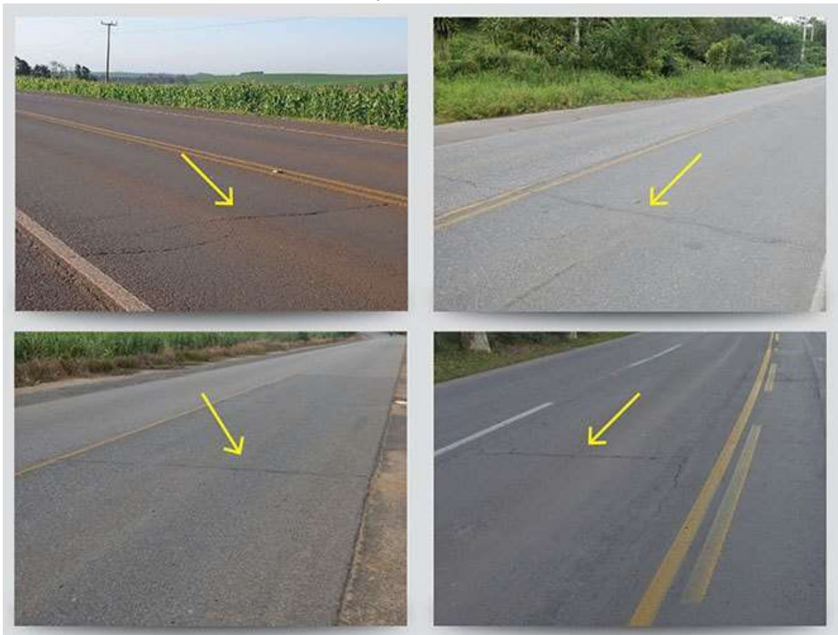
Figura 14 – Trincas transversais identificadas nas estradas em que são transportados frangos vivos para abate
