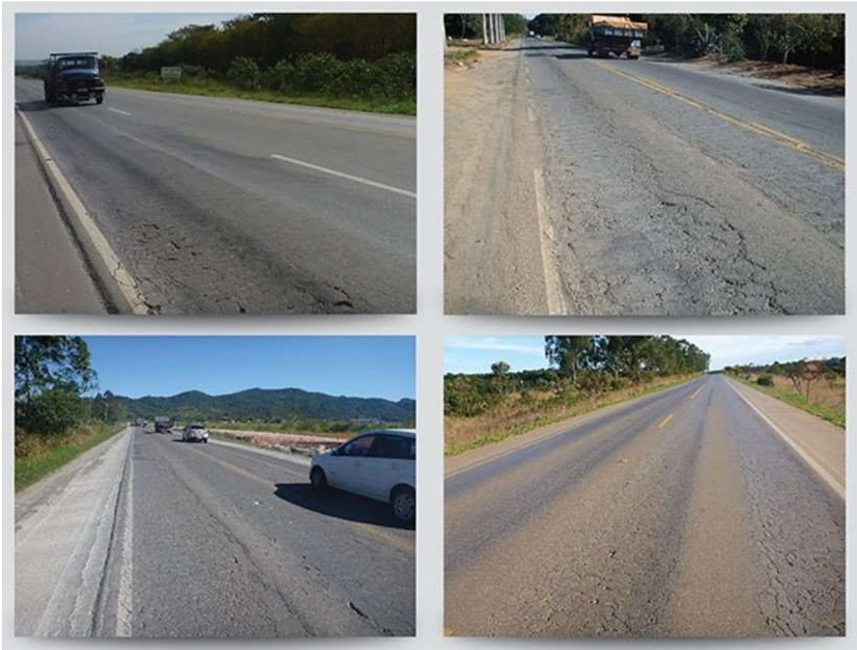
Figura 19 – Afundamento de consolidação encontrado nas estradas em que são transportados frangos vivos para abate
