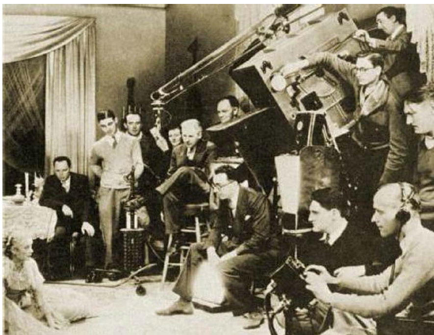
Figura 4.13: Um set de filmagem com uma câmera Technicolor Three Strips. Podemos ver claramente as dimensões da câmera, a proximidade das luzes da atriz, o aparato técnico em volta. Fatores que foram determinantes para a formação estética dos filmes daquela época.
