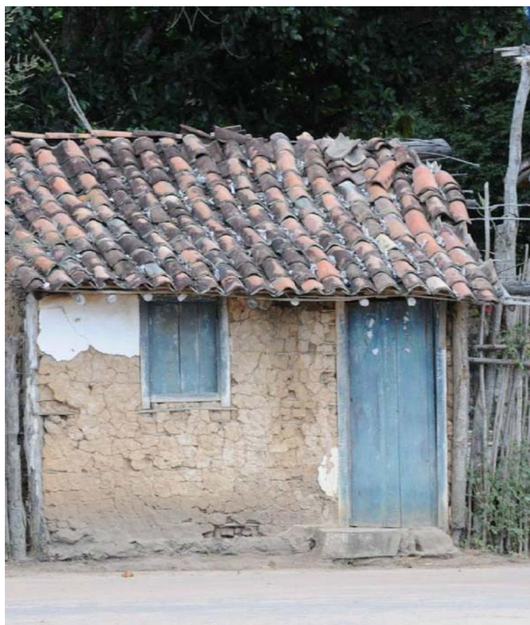
Figura 02 - Uma das antigas casas do Remanso, feita em taipa com cobertura de telhas Fonte: SU STATHOPOULOS, 2010
