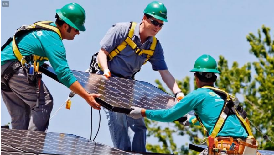
Figura 19 - Imagem de funcionários instalando painéis de energia solar da Solar City
