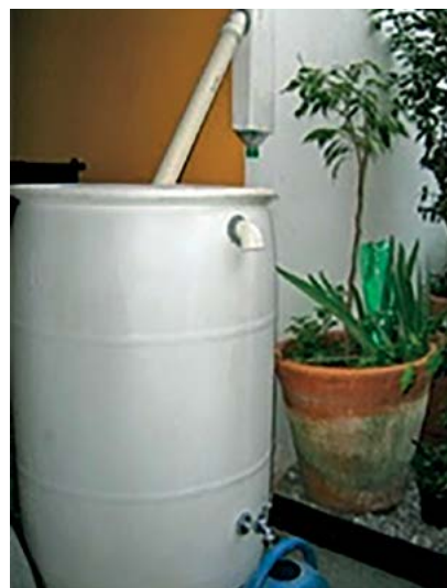
Figura 13 – Cisterna improvisada com tambor de plástico
