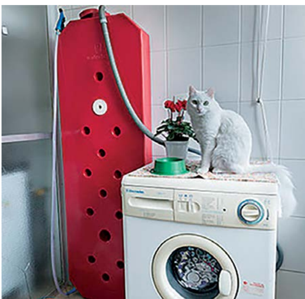
Figura 5 – Cisterna vertical modular de polietileno, com capacidade de 97 litros
