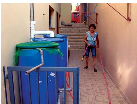
Figura 12 – Cisternas improvisadas com tambores de plástico
