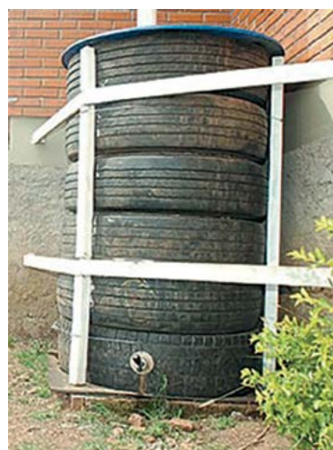
Figura 14 – Cisterna reaproveitando pneus
