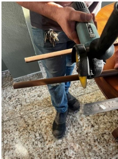
Figura 14 - Cortando os tubos de PVC
